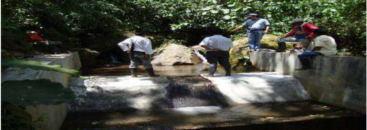
Visita y adecuación en el sistema de captación, ubicación bocatoma acueducto la victoria- municipio de Tablón de Gómez.
