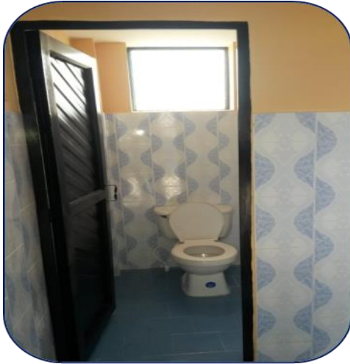
Construcción unidades sanitarias (Sandóná) (SP Cartago)
