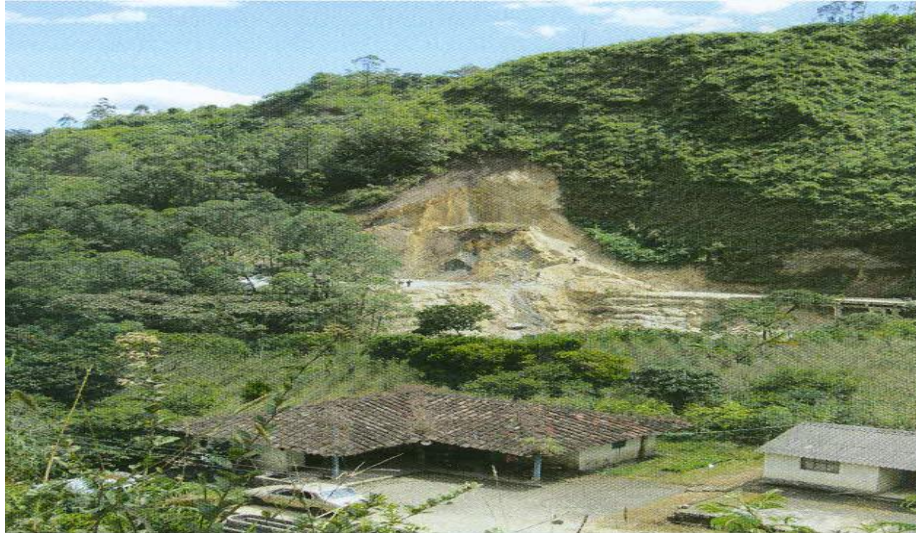
Figura 18. Desplome y caída de material en la vía a Yacuanquer-Consacá.
